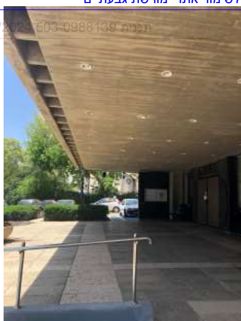
רחבת הכניסה למבנה
